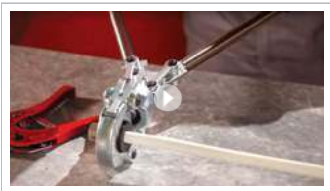
Монтаж металлопластиковых труб.
